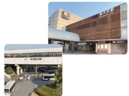
大型商業施設が集積する南大沢駅と日常生活の拠点である京王堀之内駅周辺を整備
