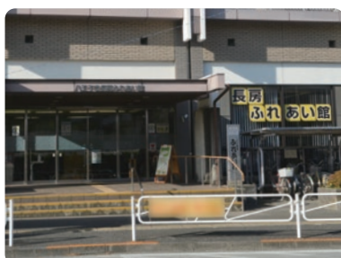
大規模改修により、6年度に一時休館を予定している長房ふれあい館
