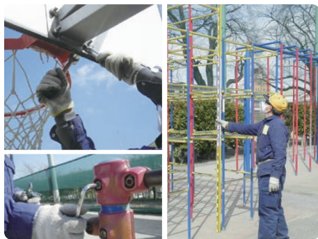
安全性確保に向けて専門業者が安全点検
