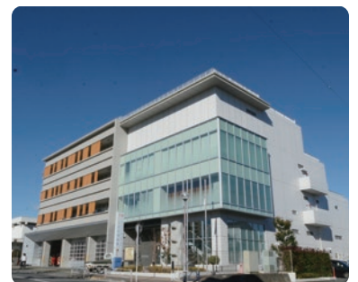
事務の合理化や消防力の強化等を目的に委託し、都が設置している八王子消防署
