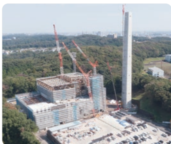
安定したごみ処理体制のため、建 設を進める新たな館清掃工場
