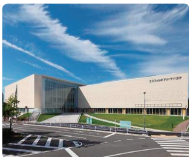
PFIにより整備した総合体育館(エスフォルタアリーナ八王子)
