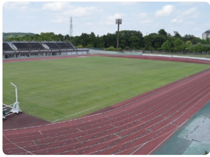
天然芝の張り替え等の改修で、安全にスポーツを楽しめる競技場へ
