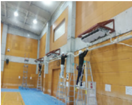
計画的に空調機設置工事が進められている市民センター体育室（川口市市民センター）
