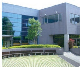
現在、改修工事のため休館している生涯学習センター川口分館
