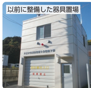
消防車両など消火用の機材を保管している器具置場
