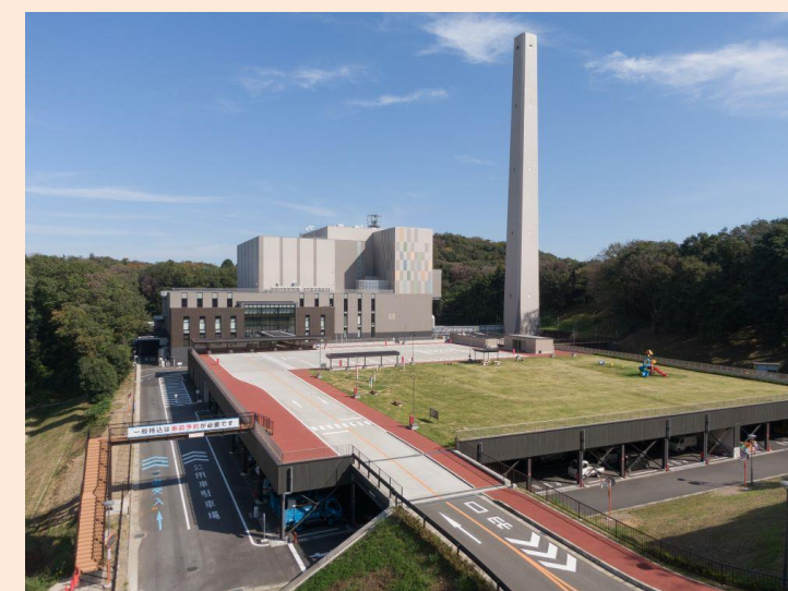
ごみ焼却時の熱で発電をする館クリーンセンター
