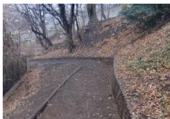
発生材の丸太を土留めとして再利用 （北野こだち公園）
