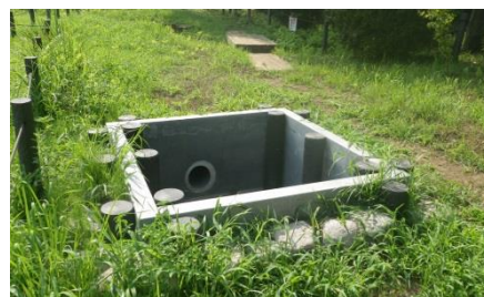
川口十二社弁天池 沈砂柵
