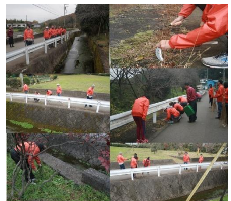
水路周りの草刈り作業
