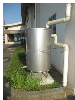
雨水貯留槽を加住事務所に設置
