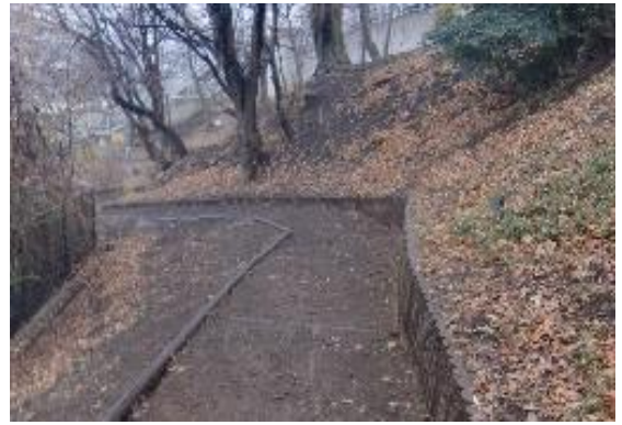
発生材の丸太を土留めとして再利用 (北野こだち公園)
