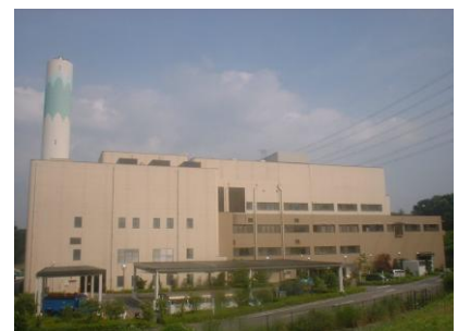
戸吹清掃工場
