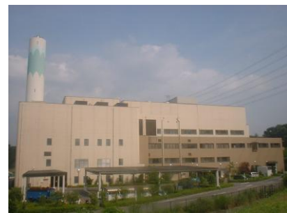
戸吹清掃工場
