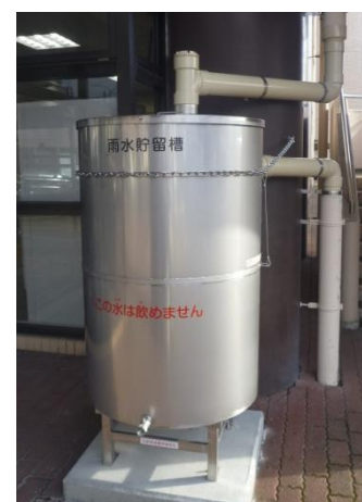
子安市民センターに設置した 雨水貯留槽
