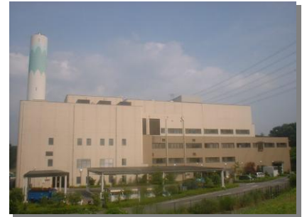
戸吹清掃工場
