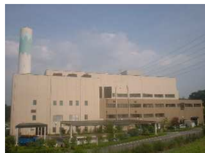
戸吹清掃工場
