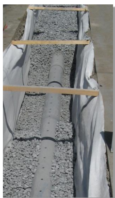
浸透トレンチ設置工事の様子
