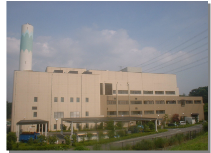
戸吹清掃工場
