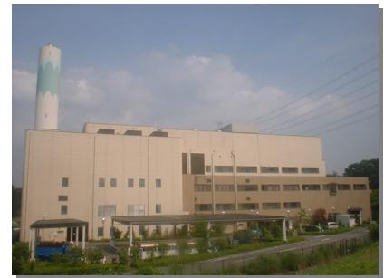
戸吹清掃工場
