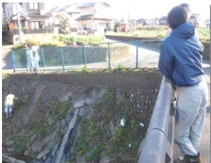
行政と生活排水現地調査
