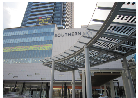
とちの木デッキの太陽光パネル
