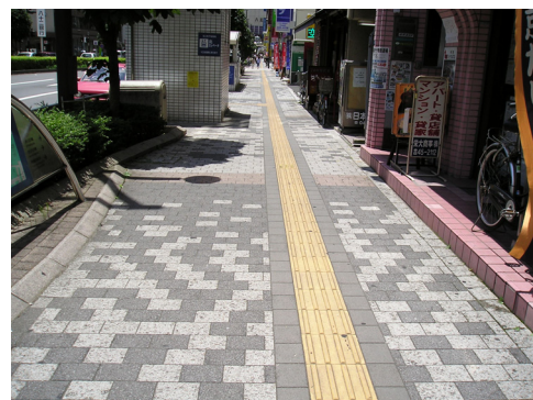
透水性舗装の歩道（桑並木通り）
