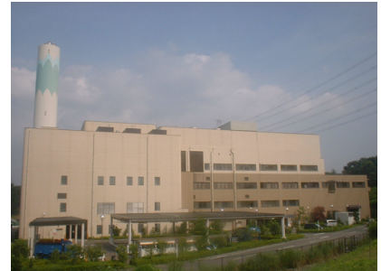
戸吹清掃工場
