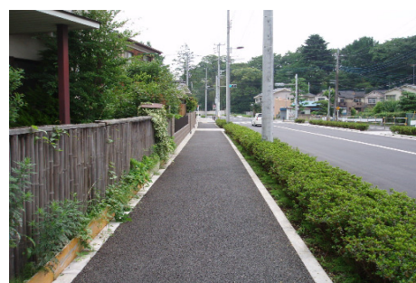
透水性舗装の歩道（中野上町三丁目）
