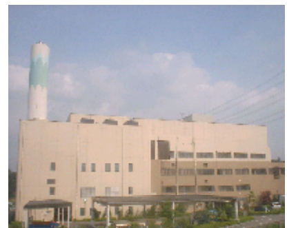
戸吹清掃工場
