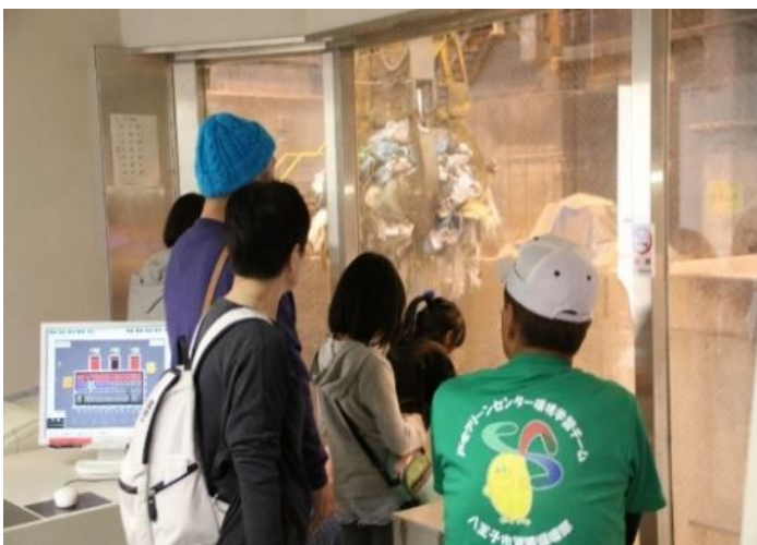
清掃工場ごみクレーン室の様子
