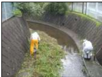
市職員の大棚川清掃状況 (9/2)
