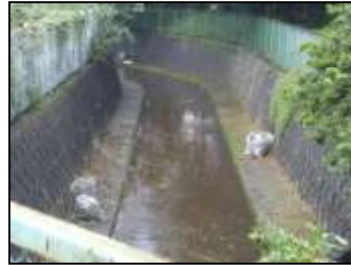
清掃後の状況
