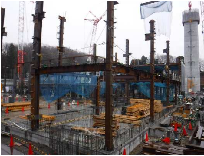
館清掃工場建設状況
