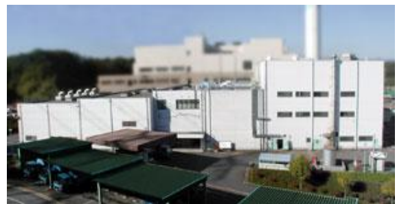
不燃物処理センター
