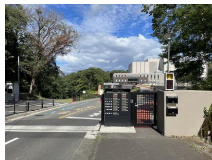
運転状況表示盤
