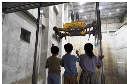
ごみクレーン
