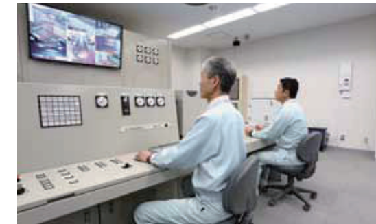
中央操作室 全ての設備を運転し管理します。機器の状態や処理の状況をモニタなどで監視し、安全で効率の良い運転を行います。
