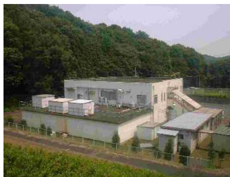
最終処分場浸出水処理施設
