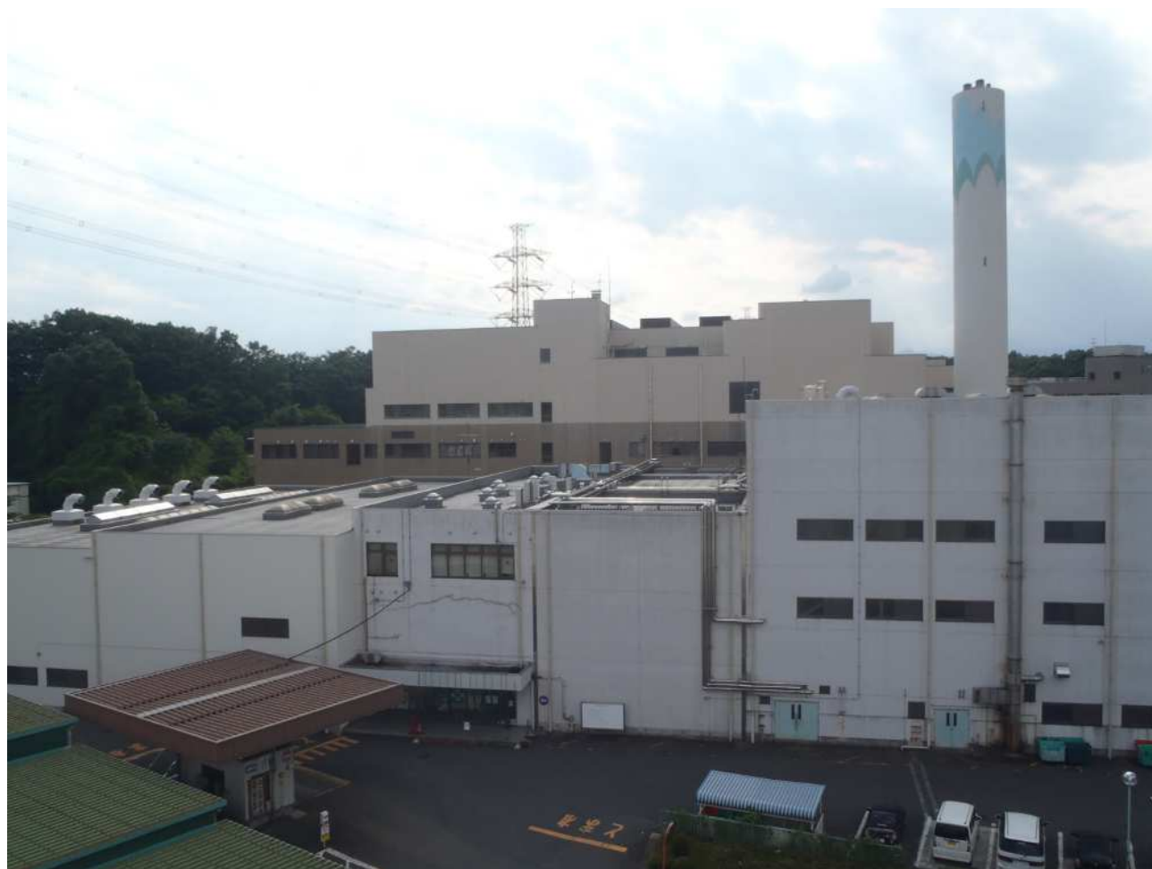
不燃物処理センター
