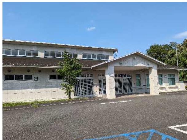
余熱利用施設「戸吹湯ったり館」
