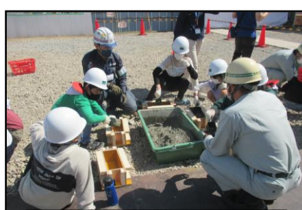
コンクリート打設体験状況
