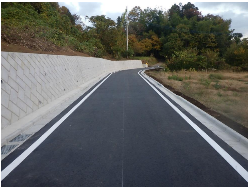
市道川口166号線道路改修その2工事
