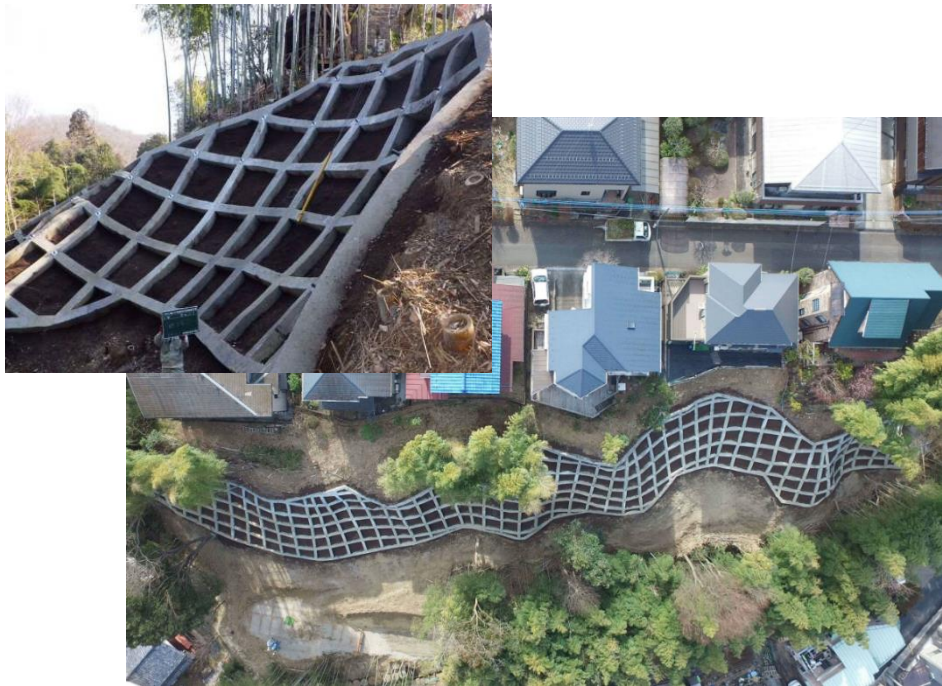
絹ヶ丘東緑地法面整備工事
