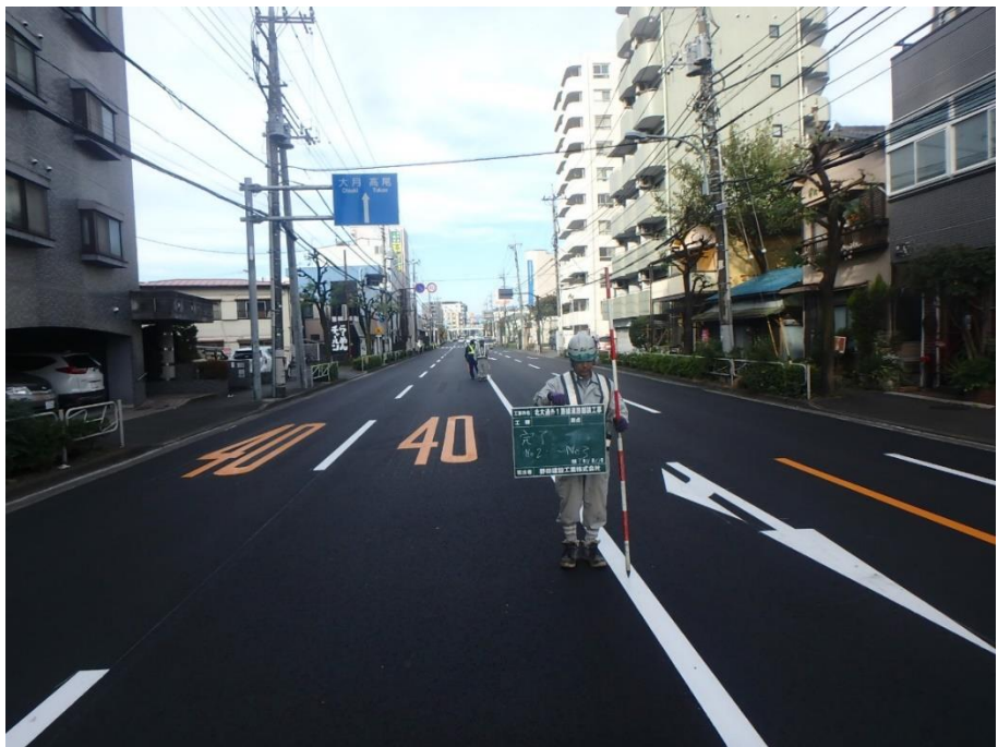
北大通り他1路線道路舗装工事
