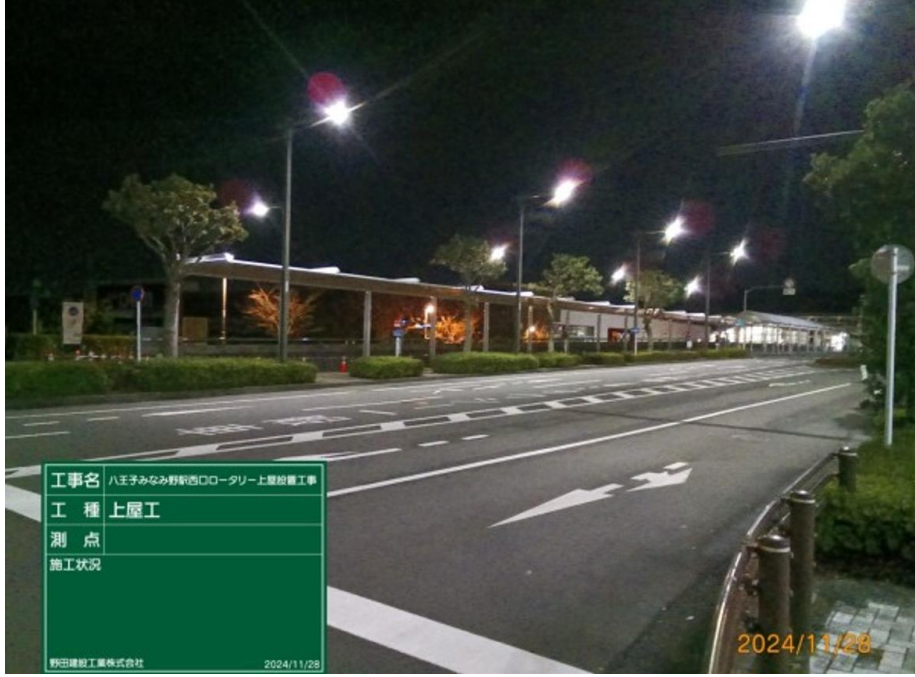
八王子みなみ野駅西口ロータリー上屋設置工事
