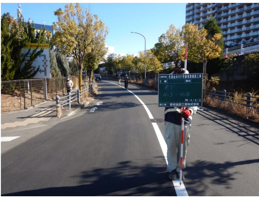
市道由木607号線道路舗装工事
