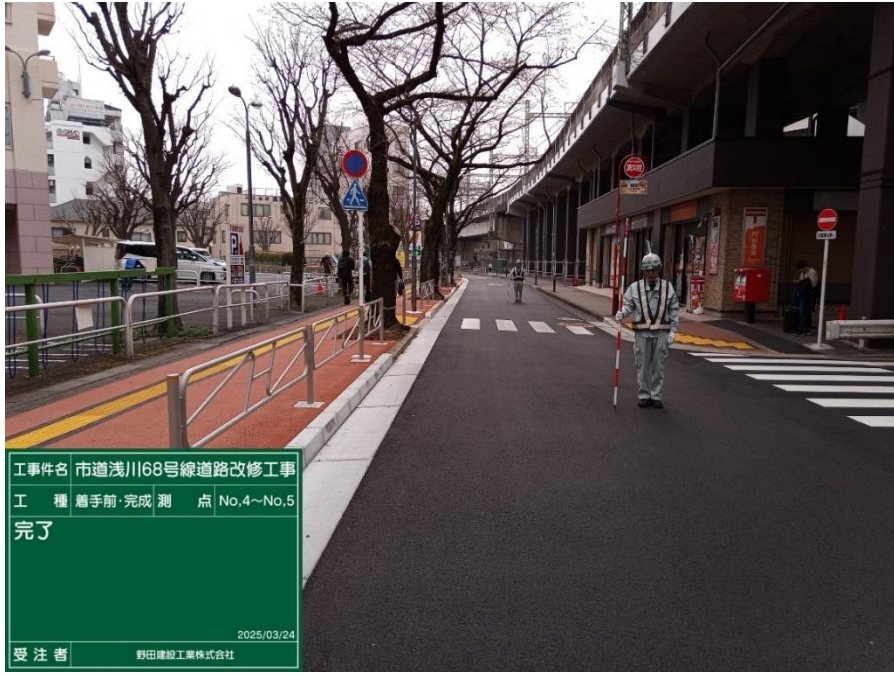
市道浅川68号線道路改修工事
