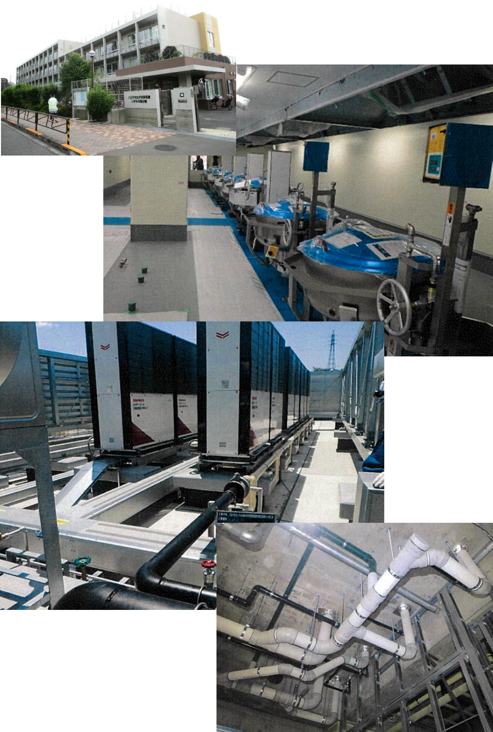
八王子市立いずみの森小中学校新築給排水衛生設備その他工事
