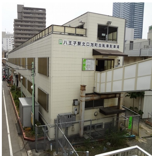
八王子駅北口有楽町自転車駐車場
