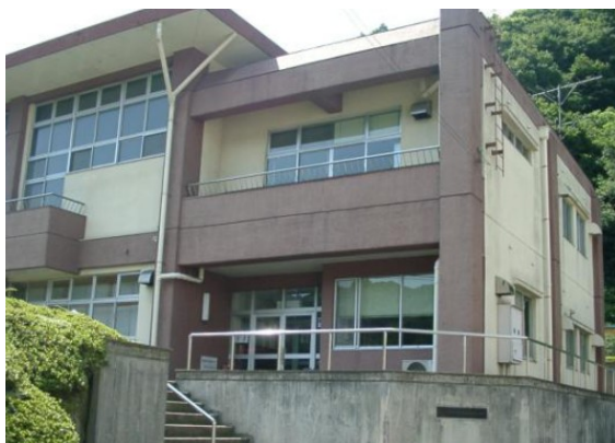
恩方農村環境改善センター
