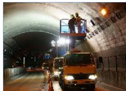
【トンネル点検の様子】
