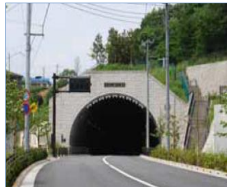
【つつじヶ丘トンネル】
