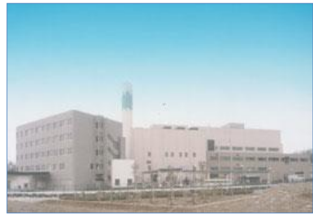
【戸吹清掃工場】
