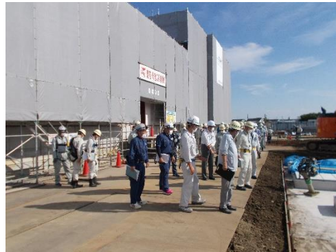
(外周工事調査)
