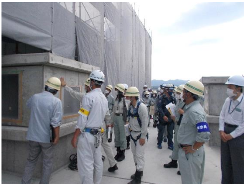
(内部工事(屋上)調査)
