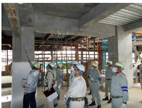
(工場棟内部工事調査)
