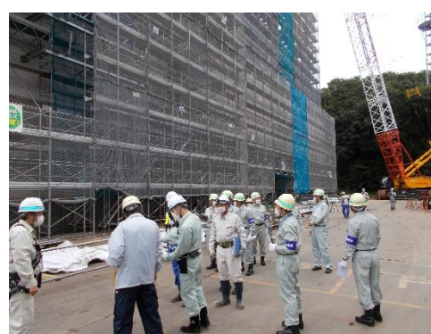
(工場棟外周工事調査)
