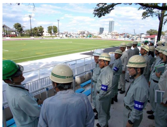
(工事実地調査)
