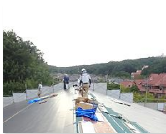
(体育館大屋根の葺き替え工事調査)
