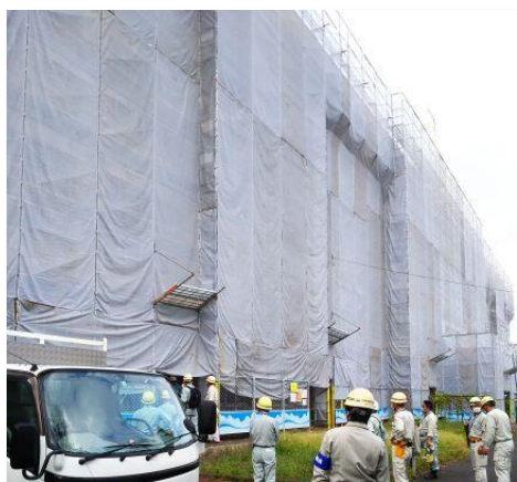
(校舎外壁工事調査)
