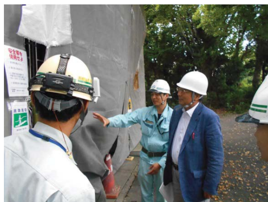
(工事実地調査)
