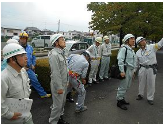
(工事実地調査)
