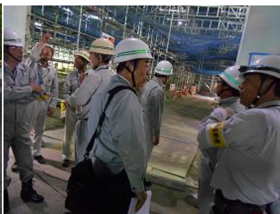
(工事実地調査)
