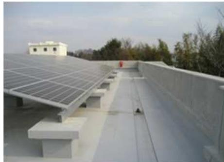
屋上防水シートの劣化に対する修繕工事を行った際に、環境対策工事の一環である太陽光発電設備を設置した改修工事です
