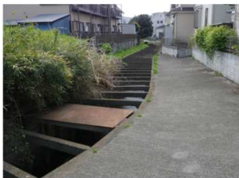
水路改良整備工事(施行前)
