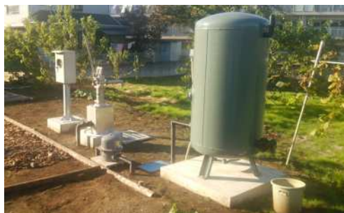
災害時には生活用水として活用が可能な防災兼用農業用井戸
